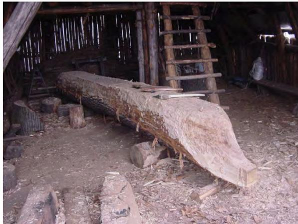
Fig. 1 Grandi lavorazioni del Neolitico. Costruzione di una piroga in una capanna.
