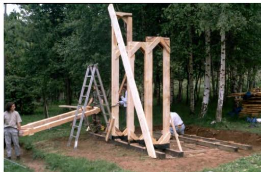
Installazione centine della struttura di prova
