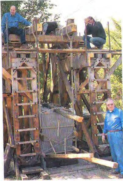
Prima soluzione – Fase iniziale del sollevamento del blocco con delle leve per recuperare l’allungamento delle corde (sistema abbandonato)
