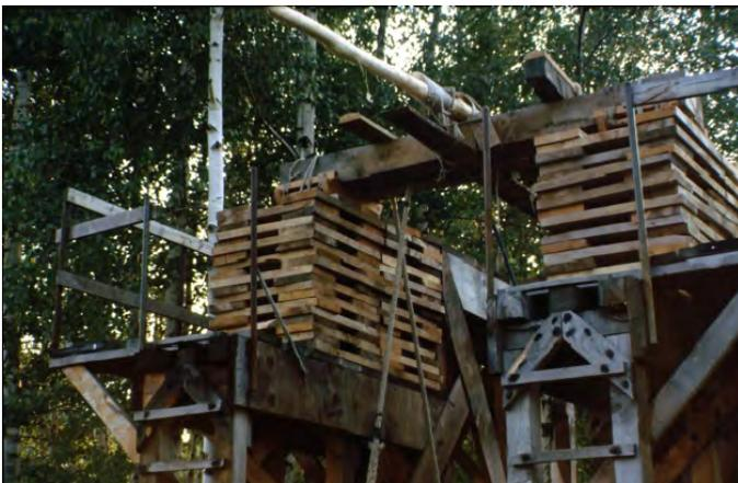
Cataste di tavole incrociate, utilizzate per il sollevamento del blocco
